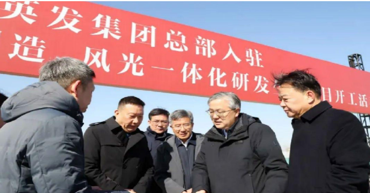
氢能储充、电子制造、风光一体化研发生产项目开工现场
