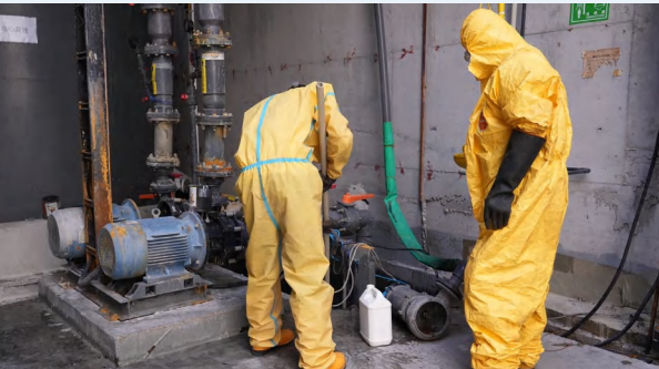
抽取地坑废水
