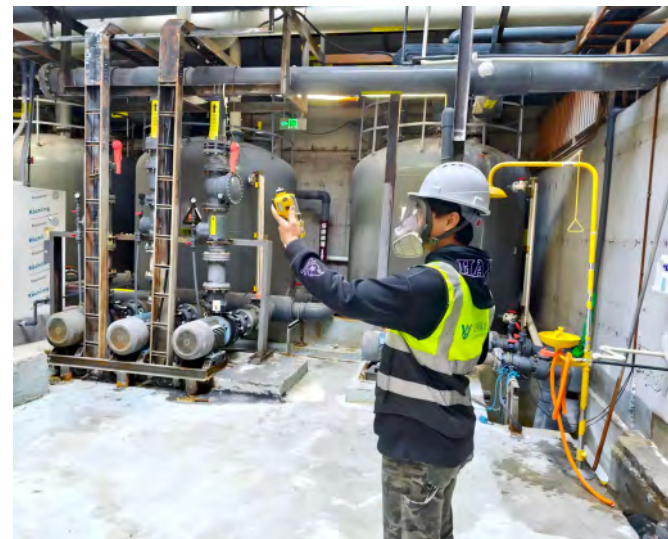
废水泄漏应急演练
